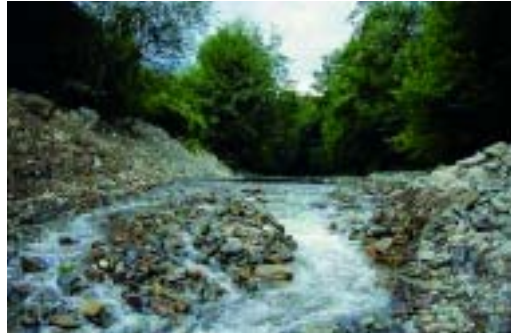
DEMOLICIÓN DE LA PRESA DE TREFILERÍAS EN EL RÍO GÁNDARA, CUENCA DEL ASÓN. LA ELIMINACIÓN DE OBSTÁCULOS ILEGALES Y FUERA DE USO AYUDA A AUMENTAR EL ÁREA ACCESIBLE AL SALMÓN Y A OTRAS ESPECIES MIGRADORAS.
