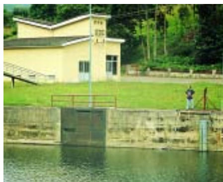
COLONIA INSTALADA EN LOS TUBOS DE DRENAJE DE UN MURO DE CONTENCIÓN DE LA ESTACIÓN DE CAPTACIÓN DE AGUAS DE AMPUERO, RÍO ASÓN.
